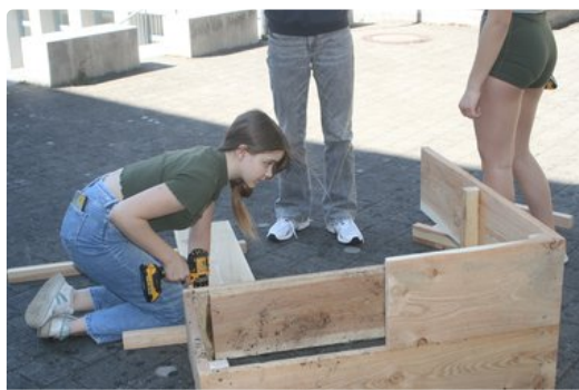
Bau der Hochbeete
